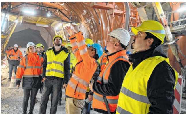
Iskopi su rađeni novom austrijskom tunelskom metodom
