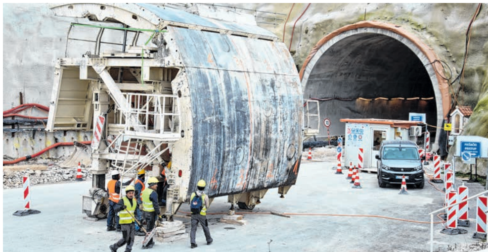
Na gradilištu radi 300 radnika
