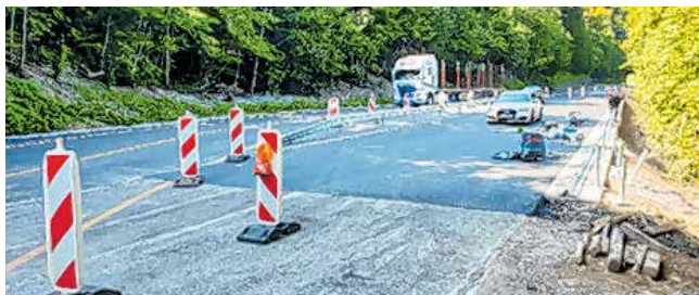
Sanacija klizišta Vodenjak
